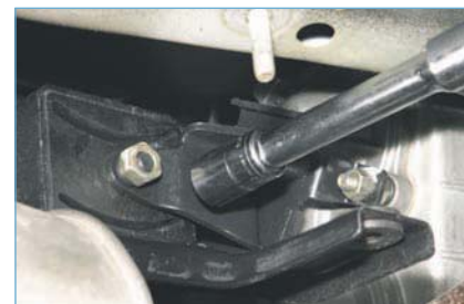
Головкой «на 17» с удлинителем отворачиваем гайку болта крепления кронштейна подвески к кронштейну раздаточной коробки...
